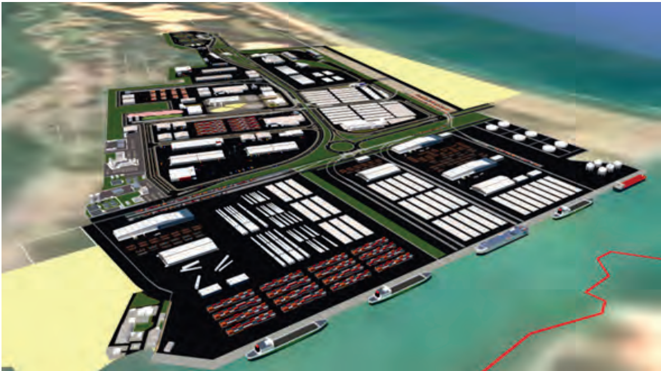
IMAGEN CON VISTA GENERAL DE LA ZONA DE DESARROLLO PORTUARIO; EN EL LADO ESTE SE OBSERVA EL PATIO DE VÍAS Y SU CONECTIVIDAD A LAS DIFERENTES ÁREAS DEL PUERTO Y SU ZDP.
