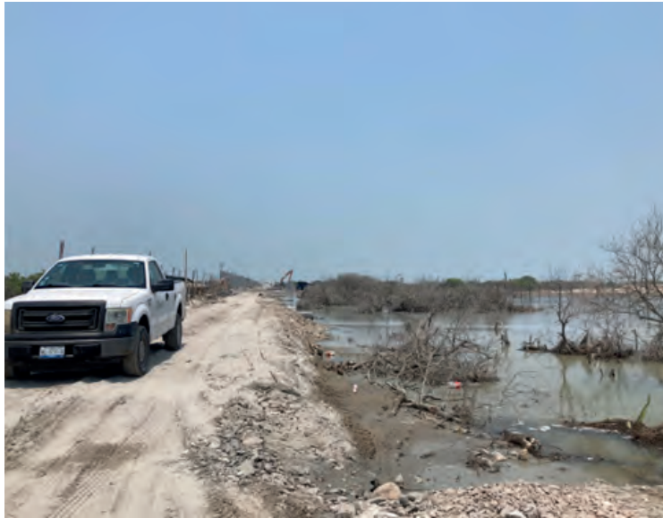
Obra de construcción de la barda perimetral del puerto
