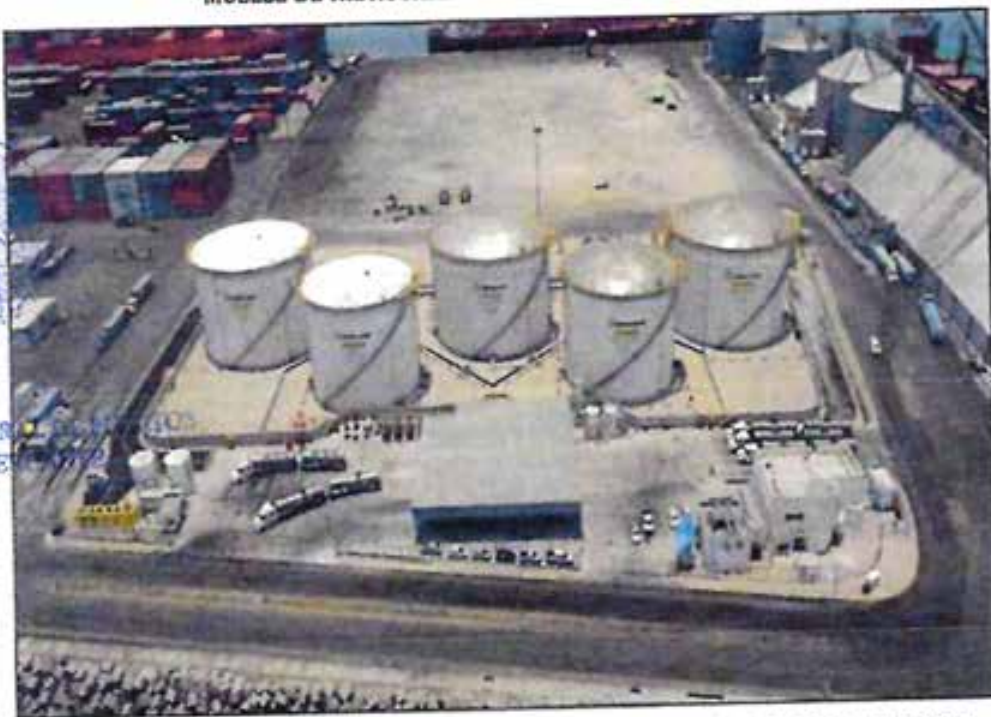
TANQUES DE ALMACENAMIENTO DE LA TERMINAL DE HIDROCARBUROS DEL SURESTE
