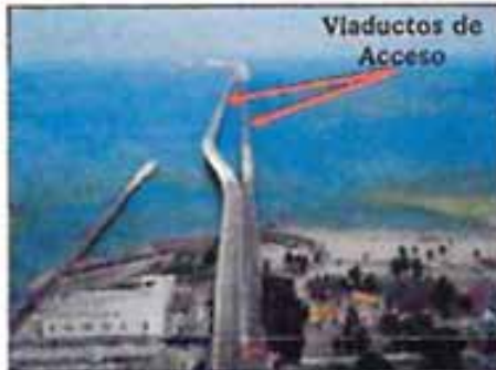
Viaductos de acceso al recinto portuario.
