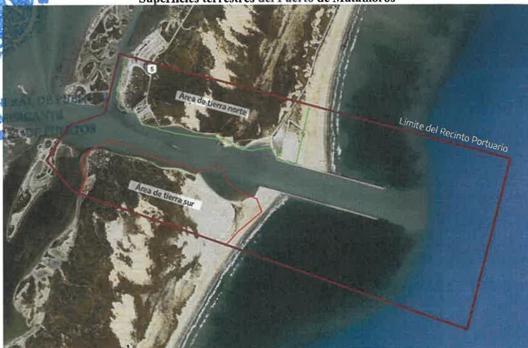
Superficies terrestres del Puerto de Matamoros
